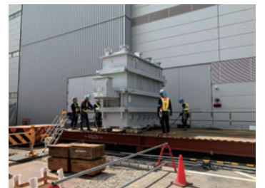
写真-1 特高トランス搬入状況
