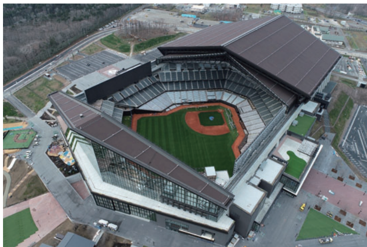
図-1 建物外観(屋根開時)
