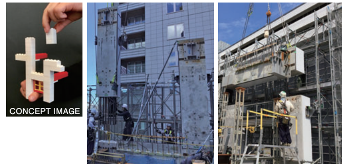
図3 PCa 建方の様子
