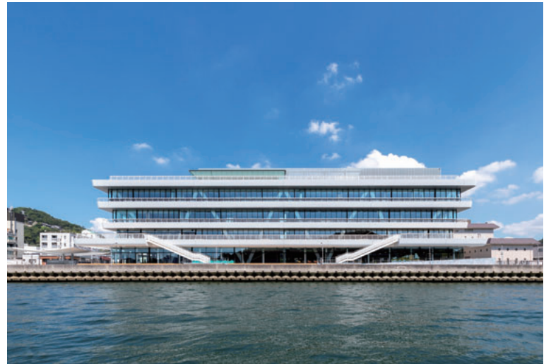
写真3 トラス柱が印象的な建物立面(南面) (撮影: SATHO PHOTO 佐藤 和成)
