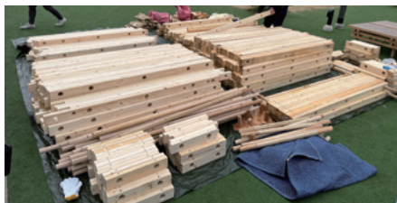
8th actionで使用した旧材に加え、木ユニットの更なる展開が可能となるよう材料を増産（左：新材、右：旧材）
