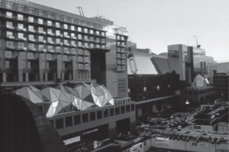
写真1 JR京都駅ビル 写真提供：アトリエ・ファイ建築研究所
