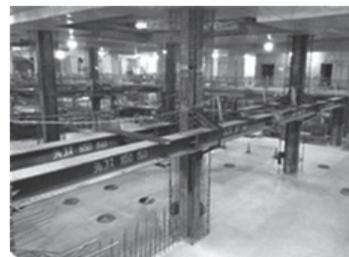
写真3 集中切梁を用いた大開口計画
