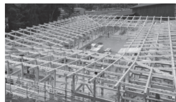
架構建て方状況
