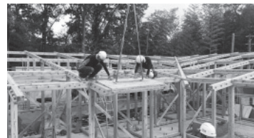
CLT落とし込み状況
