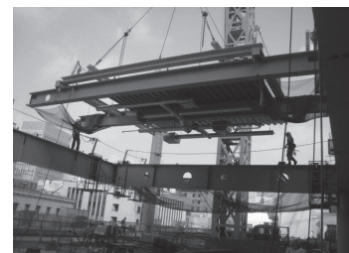
写真-2 ユニットフロア取付状況
